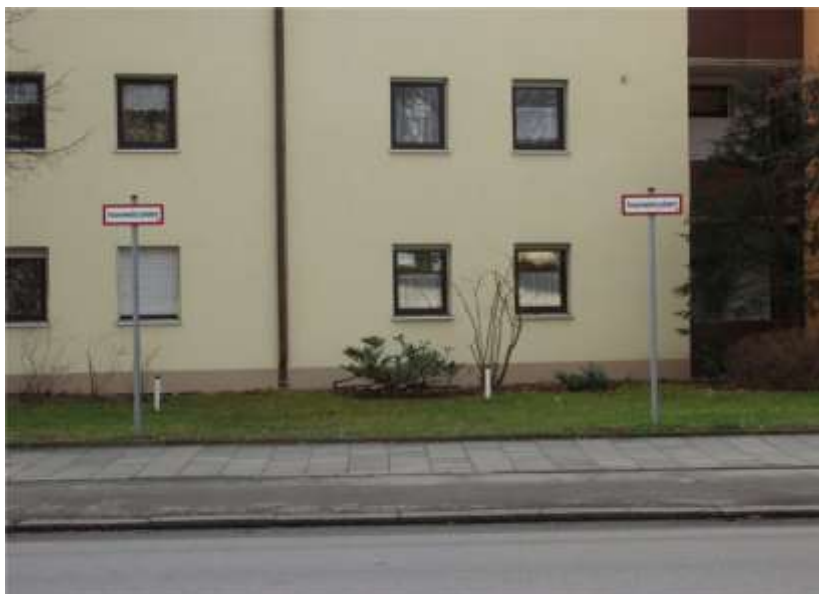
Abb. 11 – Feuerwehzufahrt über Gehweg mit abgesenkten Randstein
